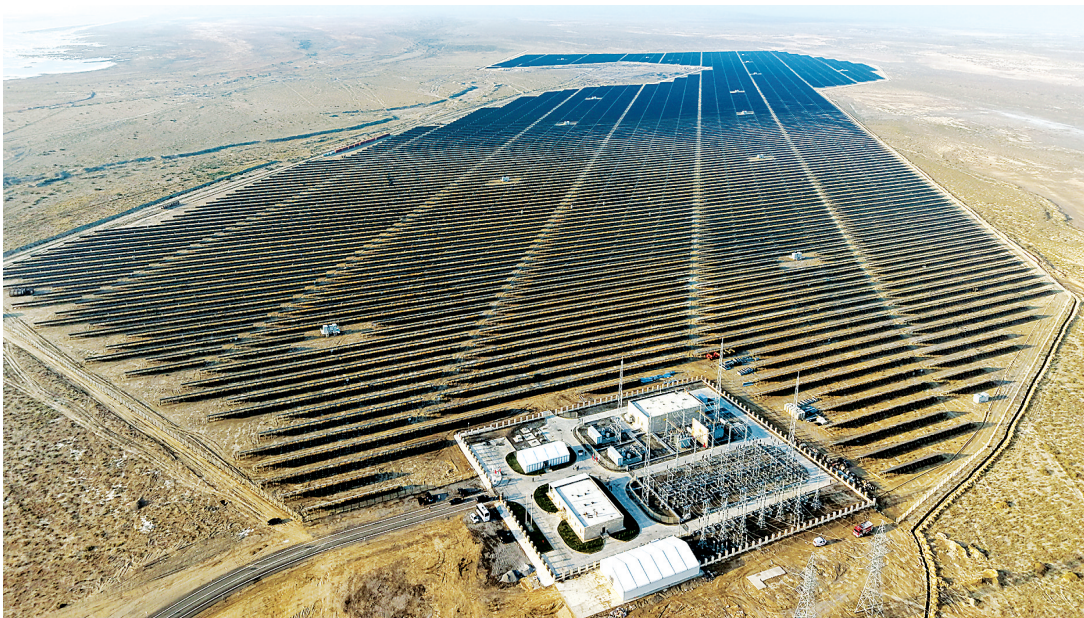
近日,由寰泰能源股份有限公司投资建设的戈布斯坦100兆瓦光伏电站项目在阿塞拜疆巴库举行并网仪式。图为在阿塞拜疆巴库市加拉达格区拍摄的戈布斯坦100兆瓦光伏电站(无人机照片)。陈俊峰/摄 新华社/阿新社
