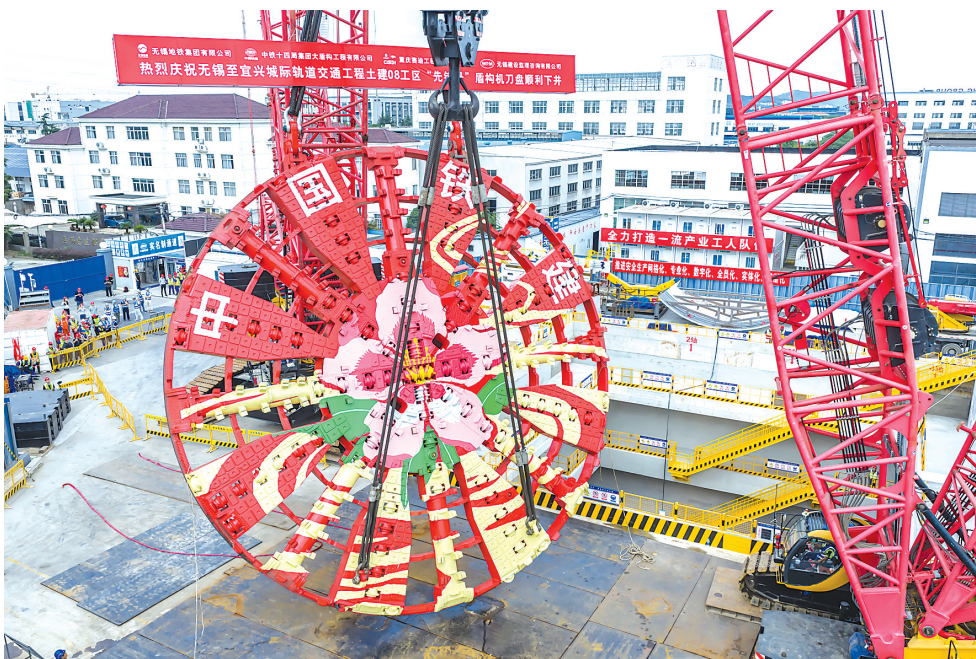
近日，在位于江苏省宜兴市的无锡至宜兴城际轨道交通工程穿太湖隧道施工现场，“先锋号”超大直径盾构机刀盘落位下井，标志着该项目的首台盾构机组装工作取得重大进展。据了解，“先锋号”盾构机开挖直径达14.02米，整机全长约112米，总重量约3200吨。 图为中铁十四局工作人员在吊装“先锋号”盾构机刀盘。
