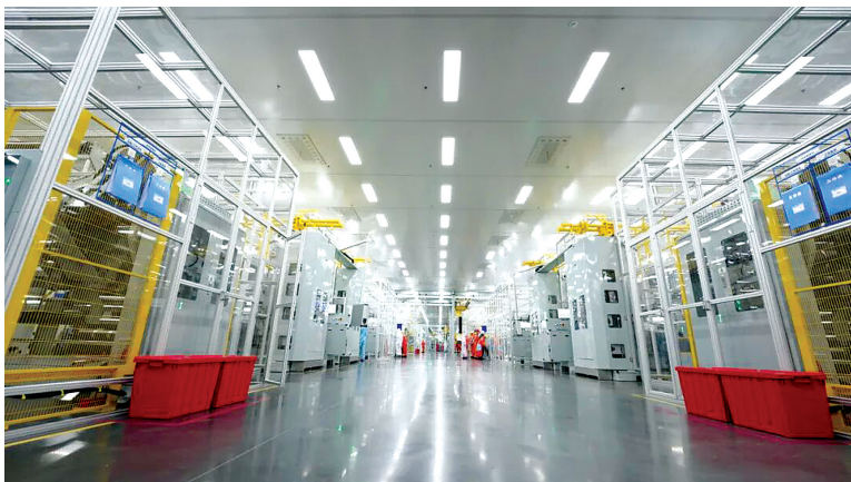
楚能新能源襄阳70GWh锂电池产业园项目投产。
