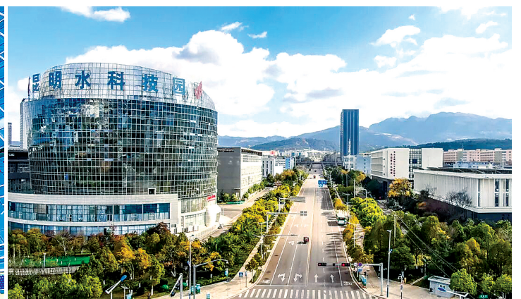
昆明水科技园
