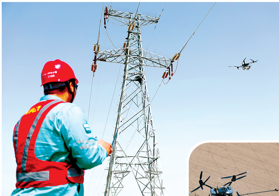
图为工作人员操作重载多旋翼无人机对110千伏沙永线70号杆塔瓷质绝缘子串开展冲洗作业。
