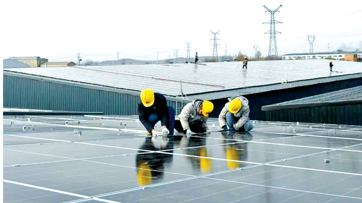
潞安太阳能公司施工安装现场
