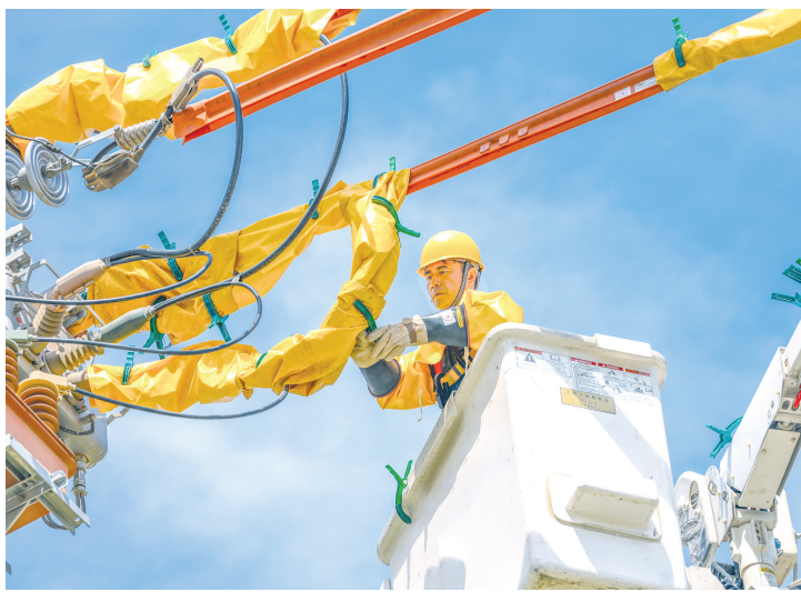
国网北京昌平供电公司配网不停电作业室班长、国网首席专家王月鹏在作业现场工作。
