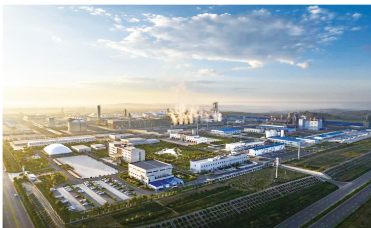
兰石化80万吨乙烷裂解乙烯项目
