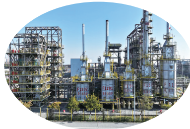
内蒙古庆华集团煤焦油加氢装置
