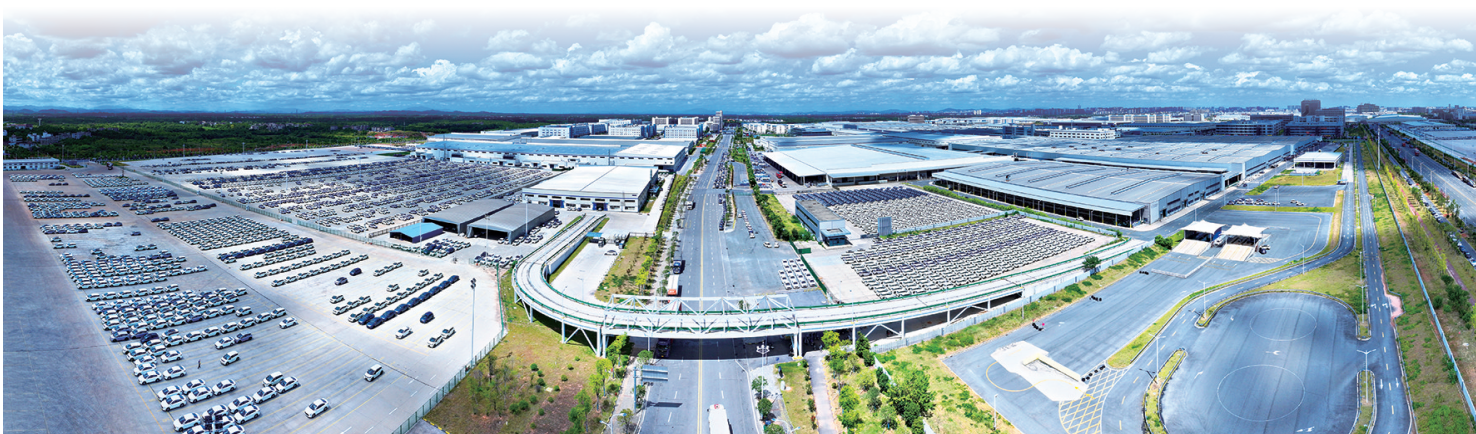
抚州新能源汽车产业园全景
