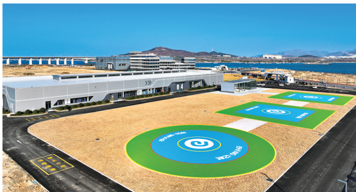
占地3800亩的低空装备产业园全面起势。
