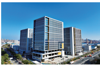
威海市首个“工业上楼”项目创新创业孵化加速器完成主体施工。
