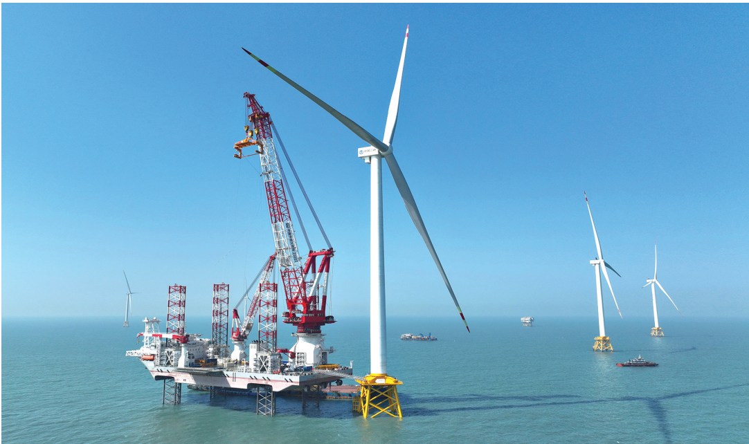
近日,由三峡集团与金风科技联合设计建造和示范应用的20兆瓦海上风电机组在福建闽南海域完成吊装。该机组的成功吊装,是我国海上风电大容量机型应用的又一重要突破。
