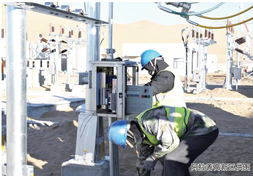
阿拉善高新区某新能源项目建设现场
