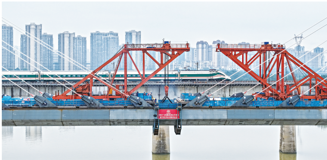
10月14日,成都至达州至万州高速铁路(简称成达万高铁)全线控制性工程遂宁涪江特大桥顺利合龙,为成达万高铁按期通车奠定基础。据悉,遂宁涪江特大桥位于四川省遂宁市船山区境内,是全线重难点控制性工程之一,大桥全长5585.4米。
