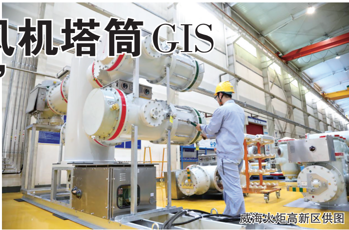
工作人员对风机塔筒GIS机械传动性能进行测试。
