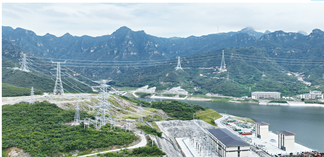
8月26日,河北省重点项目——设计装机容量120万千瓦的易县抽水蓄能电站配套工程500千伏特高压送出线路并网投运。据国网河北省电力有限公司介绍,该能源送出线路全长49.937公里,将为易县抽水蓄能电站竣工投运后发挥调峰、填谷、调频、调相等作用提供支撑,助力太行山地区的新能源消纳和保障电网安全稳定运行。
