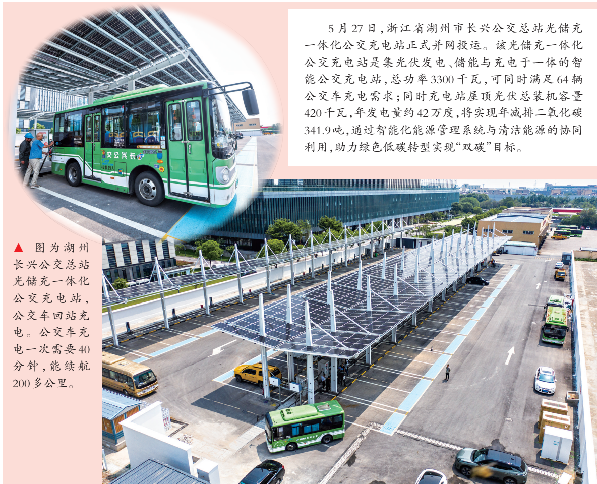
▲ 图为湖州长兴公交总站光储充一体化公交充电站(无人机照片)。
