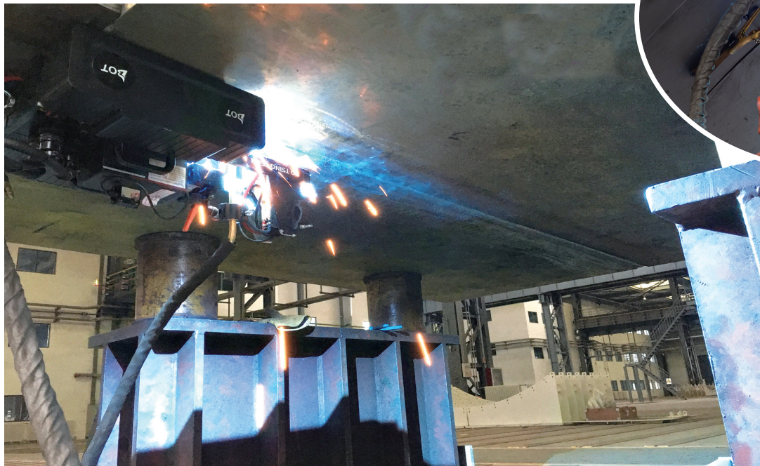
无导轨全位置爬行焊接机器人正在执行100mm超厚钢板仰焊作业。该机器人通过多传感器融合技术、焊接工艺自适应技术、焊缝跟踪技术等,攻克了厚板仰焊过程中的熔池下垂、层间融合不良等行业难题。
