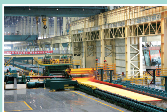
兴澄特钢150吨转炉炼钢生产线
