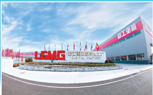
济南高新区临工重机数字化工厂
