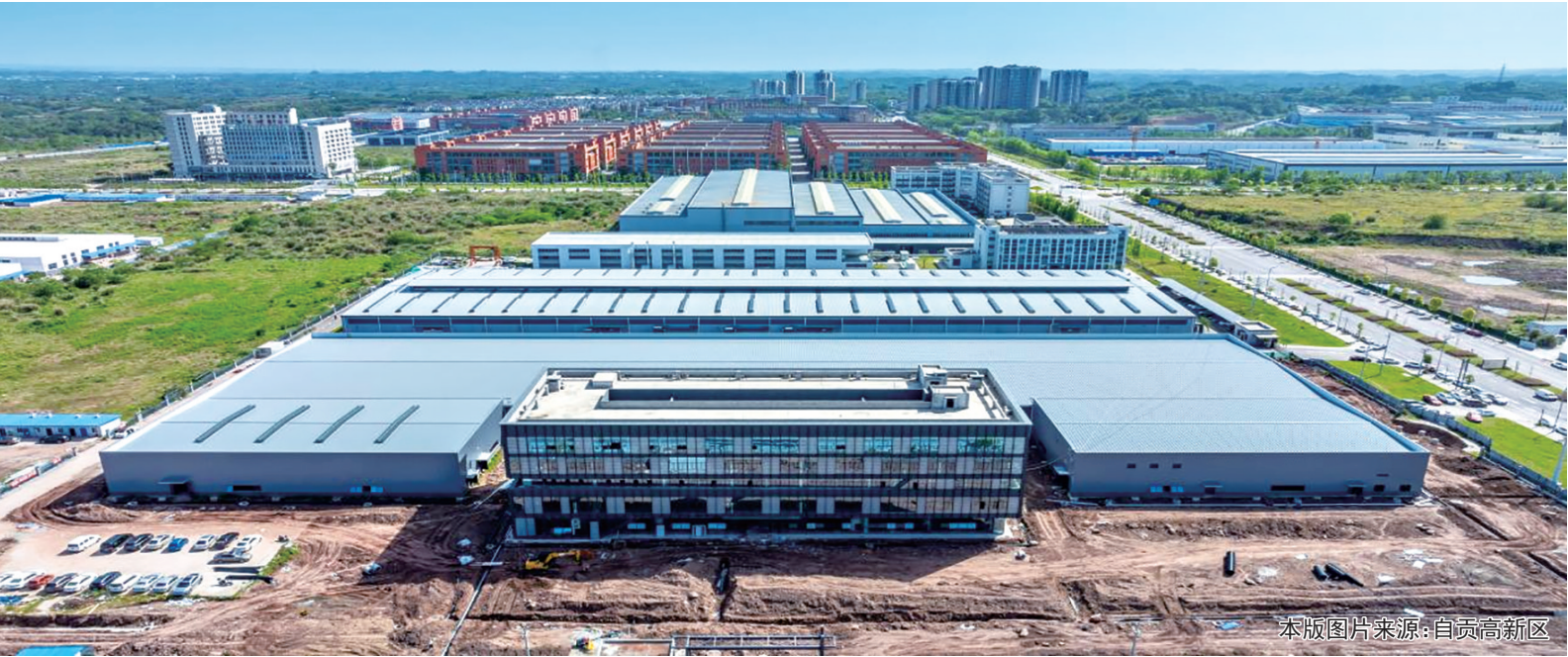
中兴能源光储智能微电网研发生产基地项目现场
