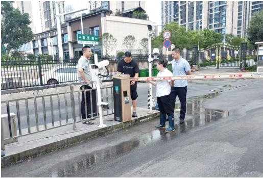
按执法部门要求拆除收费道闸。
