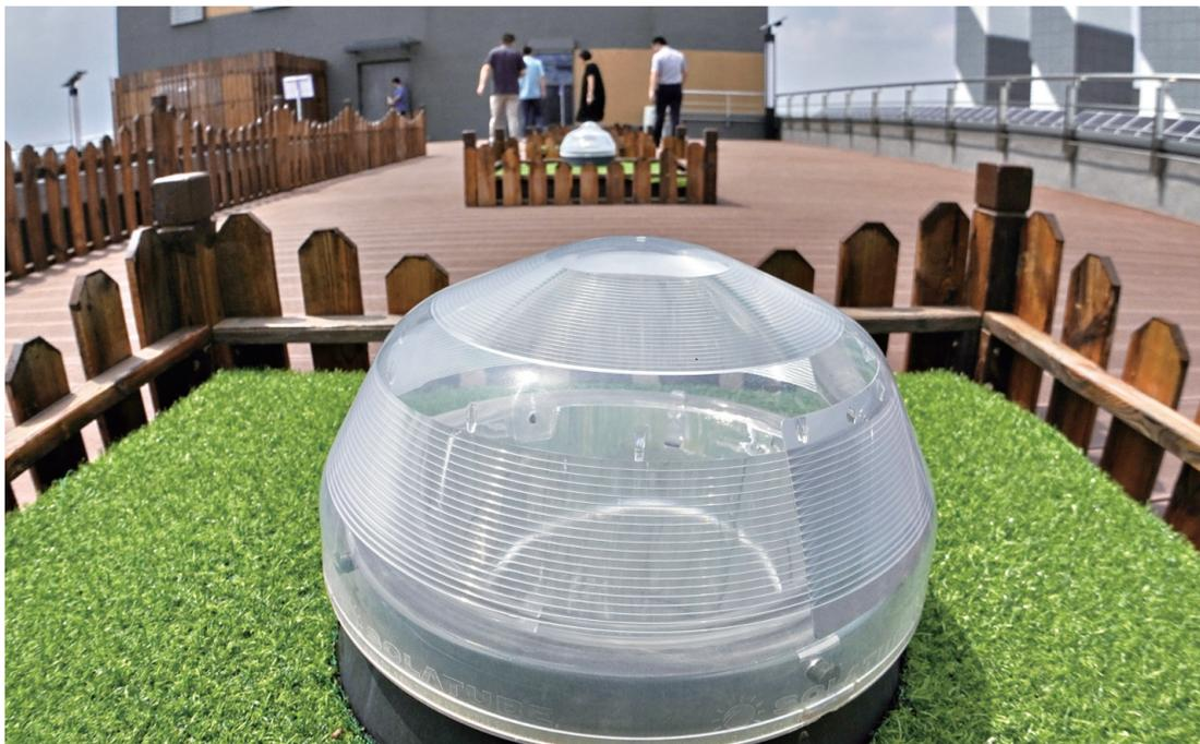
近日,北京大兴国际机场综合保税区能源中心一座由多种光伏发电技术组成的楼顶“绿电工厂”开始并网发电。这个楼顶“绿电工厂”整合安装了新型太阳能光伏、光伏建筑一体化、轻质光伏以及光热光伏一体化4项技术和设备,高效利用太阳能、空气能等清洁能源,每年可发电14.47万千瓦时。图为楼顶“绿电工厂”安装的光导管设备高效采集自然光线并把阳光引入室内照明(7月31日摄)。
