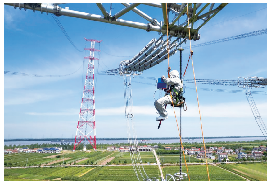
为确保迎峰度夏期间电力可靠供应,7月23日,在湖南省临湘市江南镇,国网湖南超高压输电公司对1000千伏南阳—荆门—长沙特高压交流工程荆荆满线进行带电检修。据了解,南荆长特高压工程是华中地区特高压线路主网架的重要组成部分,该线路横跨长江,通过开展此次检修,有助于提升湖南、湖北地区电力交换能力和电网安全稳定水平。
