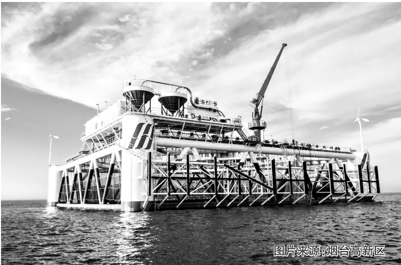
山东省“深远海设施渔业科技示范工程”深远海养殖设备经海001号
