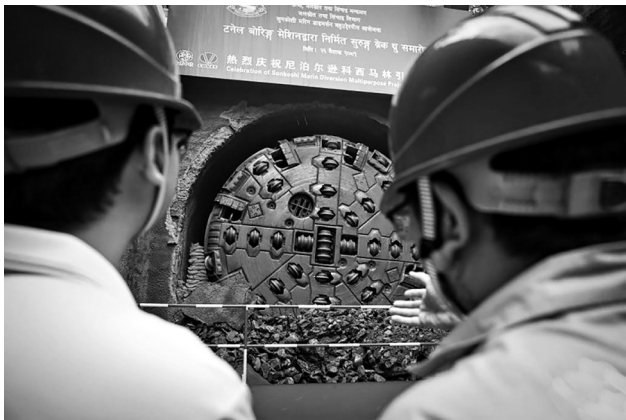
5月8日,中国企业承建的尼泊尔最大引水隧道工程逊科西马林引水隧道主体提前一年顺利贯通。这是8日在尼泊尔辛杜里地区拍摄的一台双护盾隧道掘进机打通最后一段隧道的场景。
