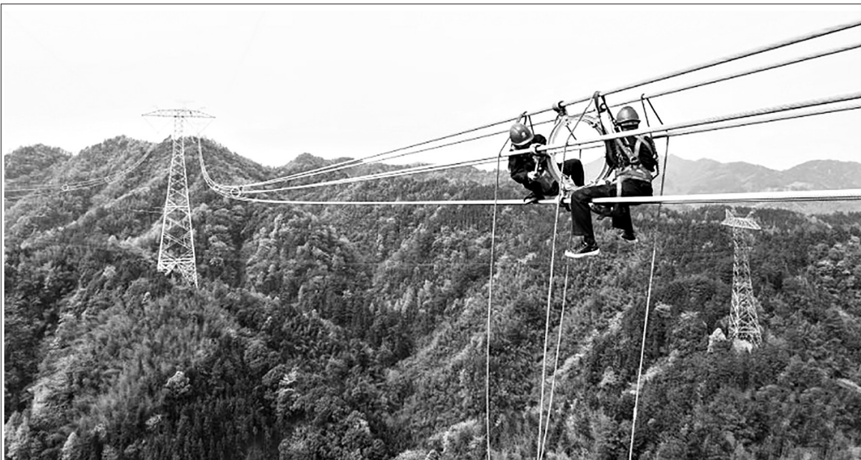
4月1日,在湖南省益阳市安化县冷市镇,湖南省送变电工程有限公司电力工人完成“宁电入湘”工程跨越宾金线架线施工,为“宁电入湘”工程早日建成运营奠定基础。据了解,“宁电入湘”特高压线路工程是我国首个沙漠、戈壁、荒漠地区风电光伏基地外送电的特高压工程。工程建成投运后,湖南将用上来自西北的清洁能源,每年可从宁夏向湖南输送电量超360亿度,减少二氧化碳排放超1600万吨,有效提升湖南地区电力供应保障能力,实现湖南中长期电力供需平衡。
