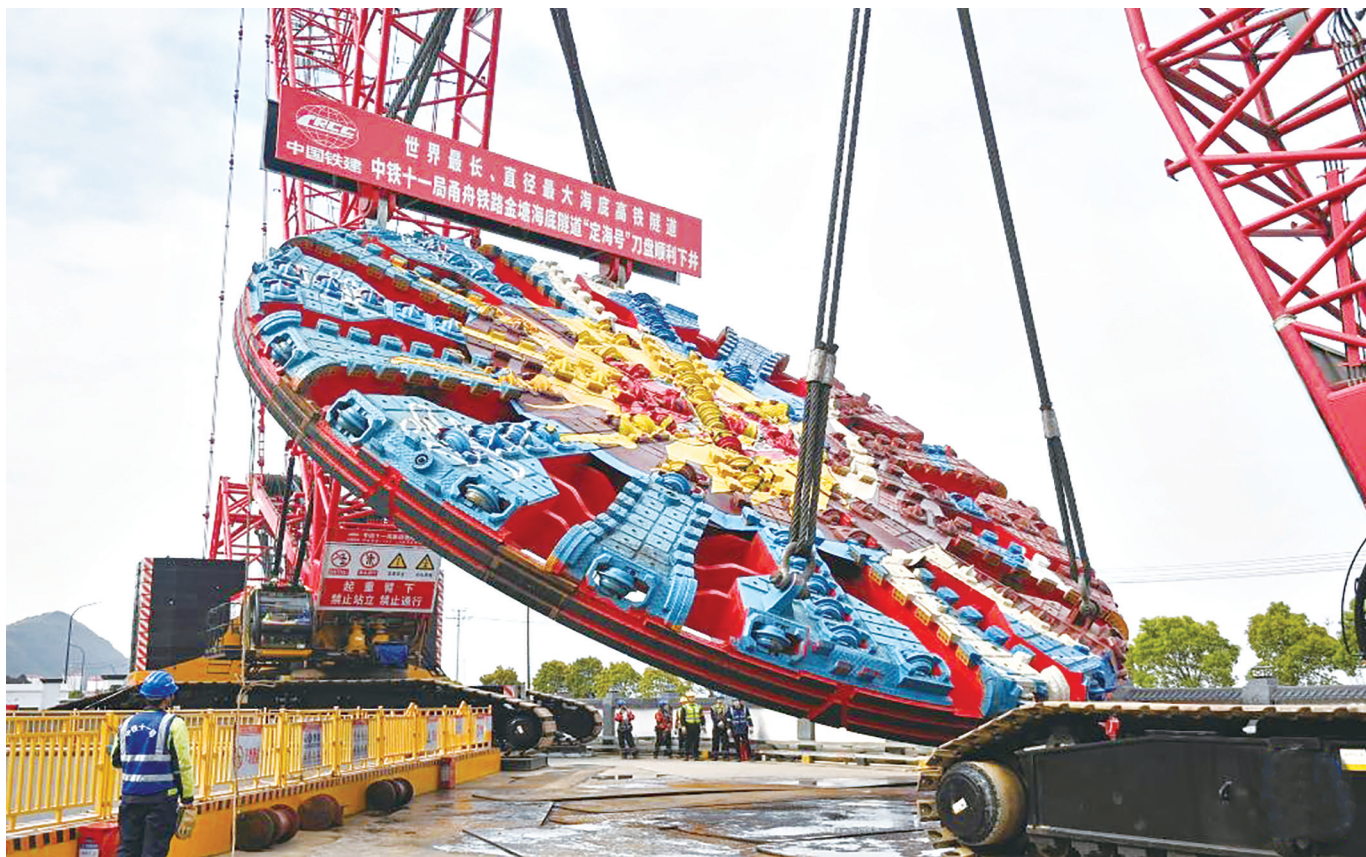
4月5日,由中铁十一局集团承建的甬舟铁路金塘海底隧道舟山侧“定海号”盾构机核心部件组装完成,为甬舟铁路金塘海底隧道盾构机始发穿海奠定基础。图为“定海号”盾构机刀盘在两台履带式起重机的协同配合下,从地面吊运至甬舟铁路金塘海底隧道舟山侧盾构始发井。
