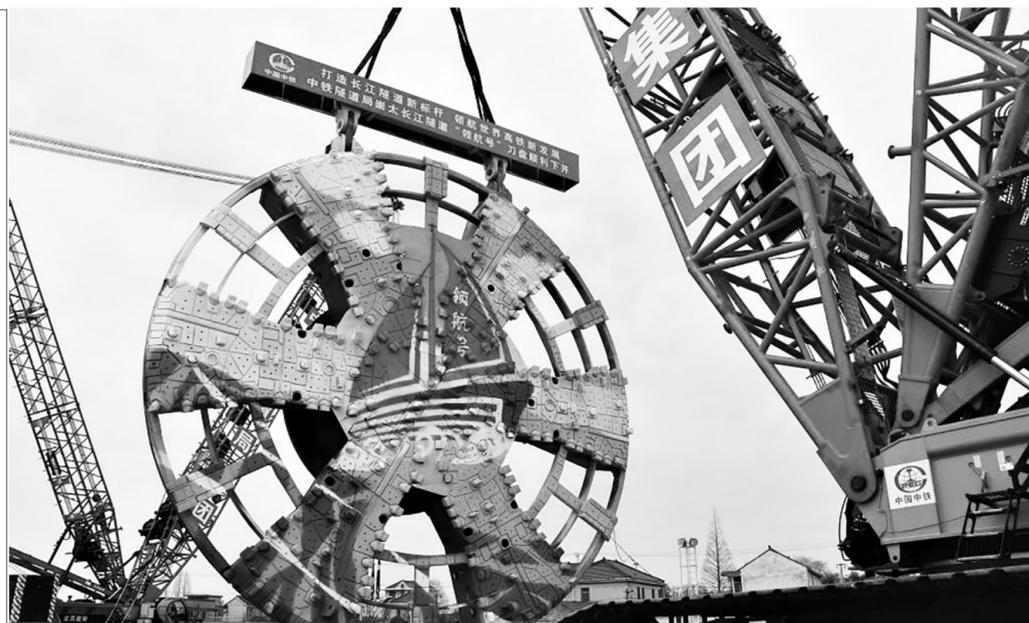
3月27日,我国自主研发的高铁盾构机“领航号”在上海市崇明区成功合体,后续将投入沪渝蓉高铁崇太长江隧道的建设。“领航号”盾构机今年1月底在杭州下线,刀盘直径15.4米,搭载智能掘进、智能拼装、超前地质预报等系统,可助力实现隧道智能建造。“领航号”盾构机调试完成后,将从上海崇明首发穿越长江。图为在上海崇明,“领航号”盾构机刀盘准备下井。
