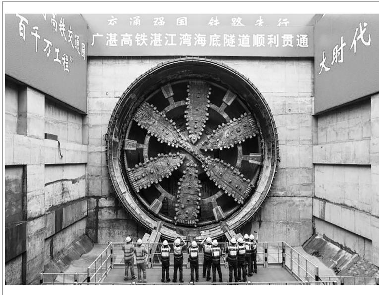
3月15日,由中铁十四局施工的广州至湛江高速铁路湛江湾海底隧道顺利贯通。该隧道由一台直径14.33米的盾构机掘进,历时33个月,掘进7551米,是目前国内独头掘进距离最长的穿海高铁盾构隧道。广湛高铁为国家“八纵八横”高速铁路网的重要组成部分,设计时速350公里。图为当日建设者在广湛高铁湛江湾海底隧道盾构接收井见证隧道贯通。
