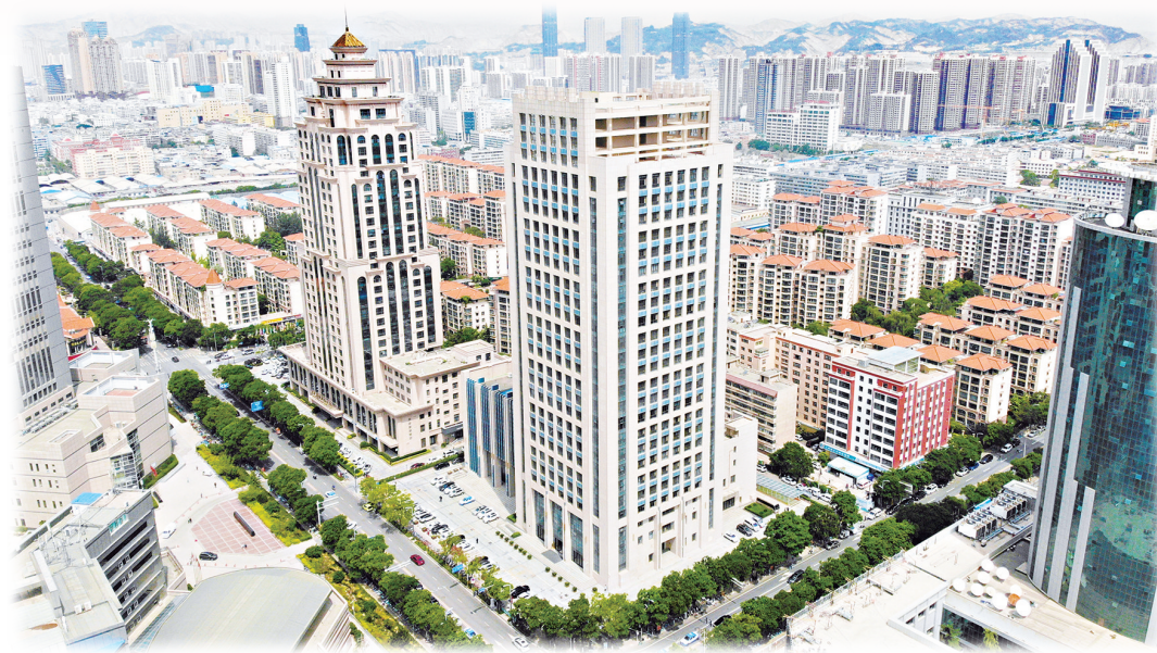
兰州高新区科技孵化大厦
