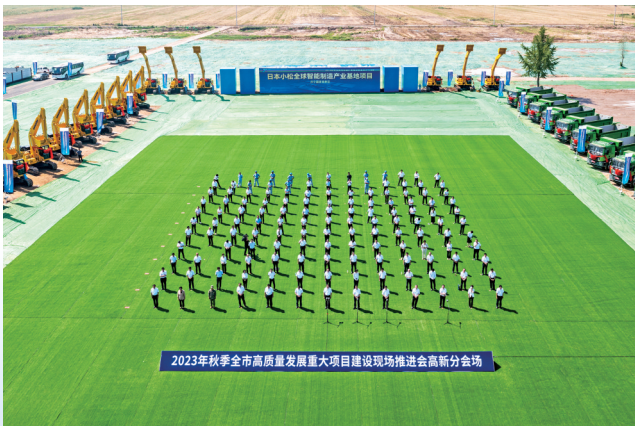
日本小松全球智能制造产业基地项目开工。
