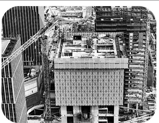
1月15日,在江苏省南京市江北新金融中心一期项目施工现场,承建方中建三局运用“空中造楼机”进行项目封顶的最后一次顶升作业,各项施工稳步推进。据介绍,该项目建造采用智能集成“空中造楼机”,提高了高层建筑施工的机械化、智能化及绿色施工水平,让“高空作业”变为“室内施工”,施工效能提升约20%。这是当日拍摄的南京市江北新金融中心一期项目施工现场(无人机照片)。
