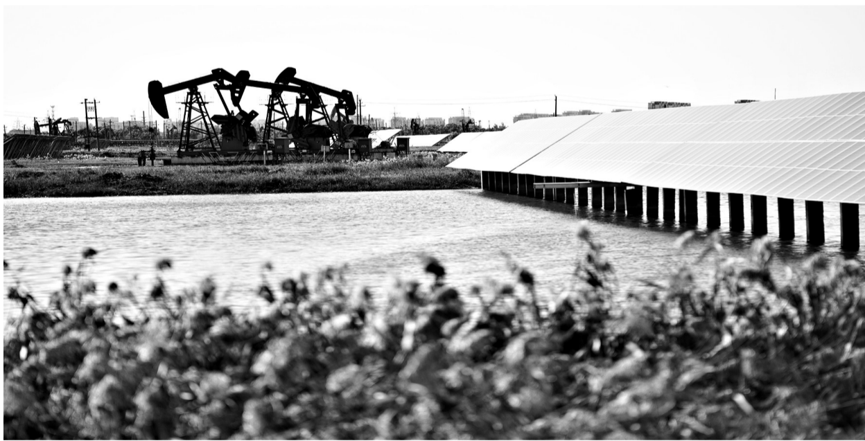
中国石油首个水面光伏项目——大庆油田星火水面光伏电站,是积极响应国家“双碳”战略目标、贯彻落实中国石油“清洁替代、战略接替、绿色转型”总体部署、打造“大庆油田绿色低碳可持续发展示范基地”的先导示范工程。该电站装机规模18.73兆瓦,年平均发电量折合火力发电标准煤8400吨,可减少二氧化碳排放量2.2万吨。去年6月30日并网发电以来,电站运行平稳,各项指标参数均达到设计要求,截至今年8月末,已累计发电3300万千瓦时,全部由油田负荷自行消纳,为油田“清洁充电”。图为9月19日在大庆油田星火水面光伏电站,电站设施与附近的抽油机相映成趣。新华社记者 王建威/摄
