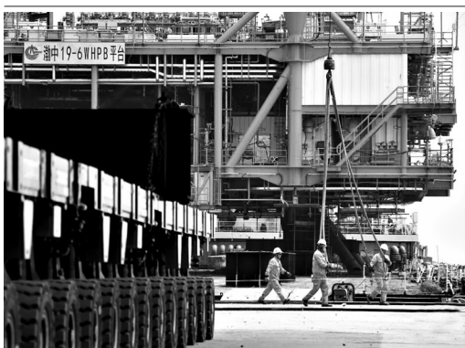
8月9日,随着3座井口平台通过验收,中国渤海首个千万方大气田渤中19-6凝析气田1期开发项目的海上开采平台在油田工程天津智能化制造基地建造完工,为年内顺利投产提供了关键装备保障。渤中19-6凝析气田位于渤海中部海域,是中国东部第一个大型、整装、高产、特高含凝析油的千亿级立方米凝析气田。图为当日在天津滨海新区油田工程智能化制造基地,工人进行组块装船前的准备工作。
