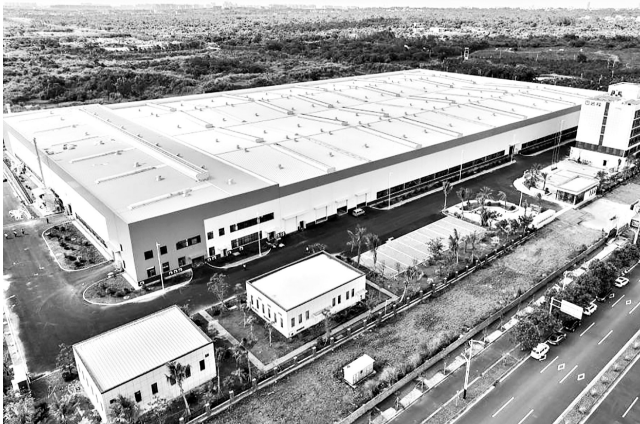
海口高新区新能源技术生产研发平台EPC项目(无人机照片)
