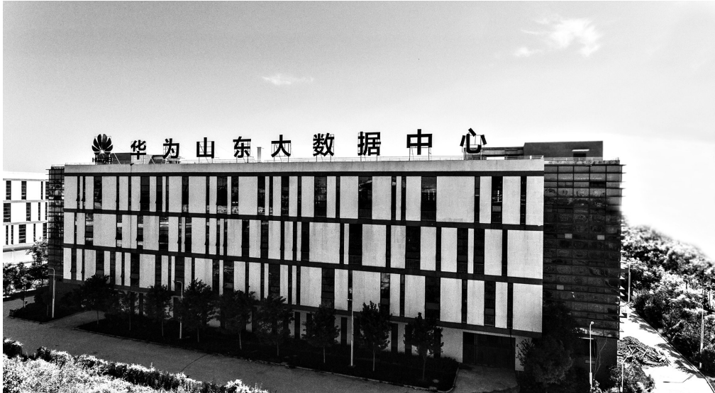
位于济宁信息产业园的华为山东大数据中心
