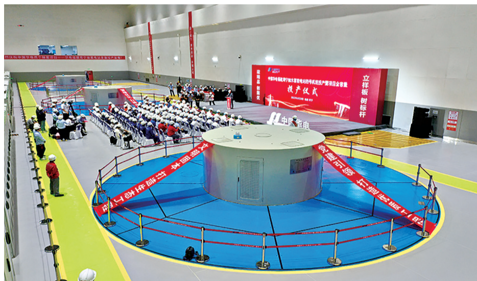
福建周宁抽水蓄能电站地下厂房
