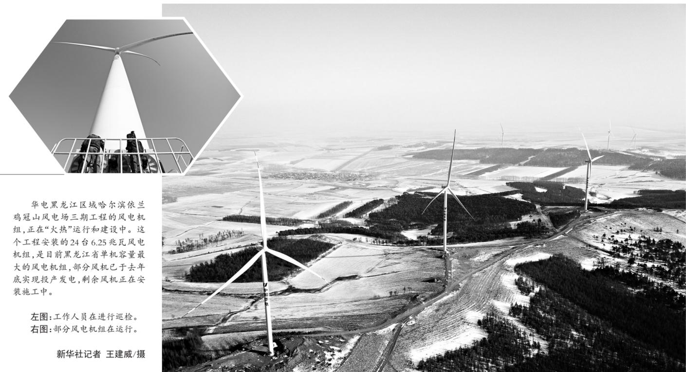
华电黑龙江区域哈尔滨依兰鸡冠山风电场三期工程的风电机组,正在“火热”运行和建设。这个工程安装的24台6.25兆瓦风电机组,是目前黑龙江省单机容量最大的风电机组,部分风机已于去年底实现投产发电,剩余风机正在安装施工中。
