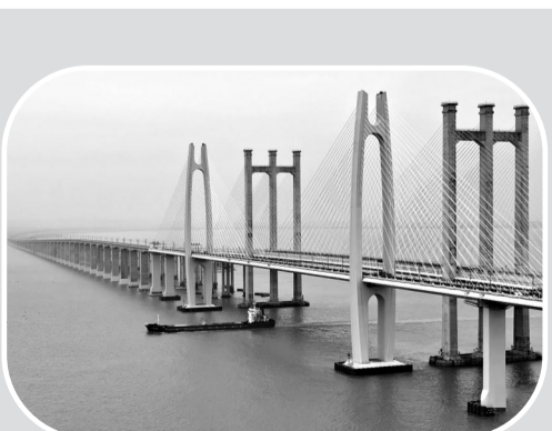
2月3日,我国首条跨海高铁——福厦高铁进入静态验收阶段,标志着该高铁全线主体工程及其配套工程建设已基本完成,距离线路今年开通运营更进一步。这是2月4日拍摄的新建福厦铁路泉州湾跨海大桥(无人机照片)。
