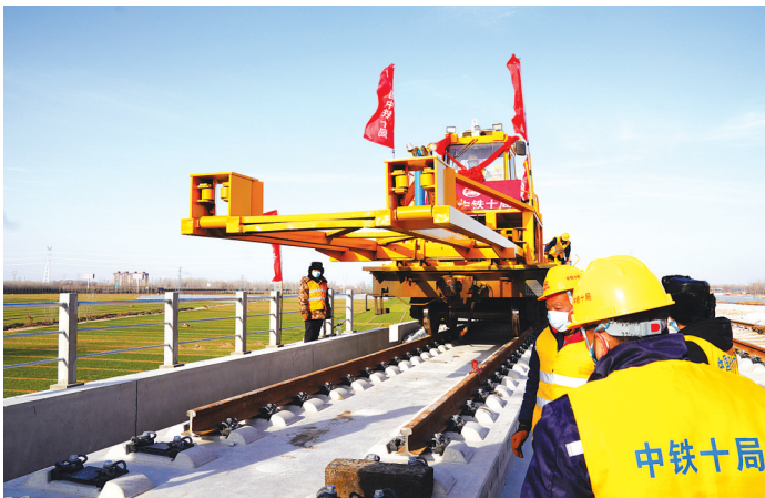
12月15日,济(南)郑(州)高铁(山东段)铺轨开工仪式在聊城举行,随着第一对长500米的钢轨缓缓入槽,标志着济郑高铁(山东段)开启全面铺轨建设。图为中铁十局的工作人员在进行铺轨作业。
