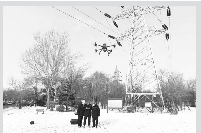
近日,我国最北省会城市哈尔滨迎来降雪降温天气,为保障电力供给,“巡检飞手”、国家电网黑龙江电力哈尔滨供电公司智能巡检中心负责人于洋来到单位驻守,开展日均6小时以上的电力线路和设备巡视检查工作,确保电网可靠运行。图为于洋(右)与同事在哈尔滨市进行输电线路无人机智能巡检。 新华社记者 王松/摄
