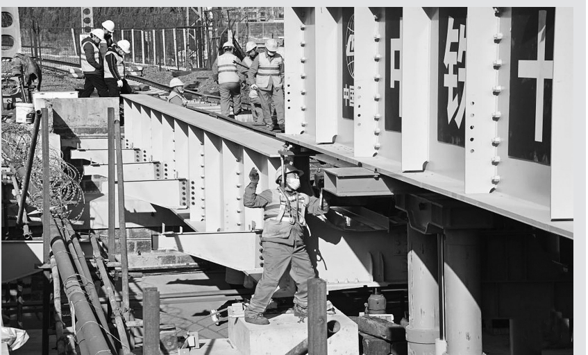
12月5日,有着百年历史的胶济铁路山东青岛海岸路段钢梁桥换梁顺利完成。据了解,铁路建设者通过仿真模拟、数据验算等技术手段,确保了旧梁拆除、新梁更换施工准确。图为中铁十四局建设者在对青岛海岸路段钢梁桥进行钢梁更换作业。
