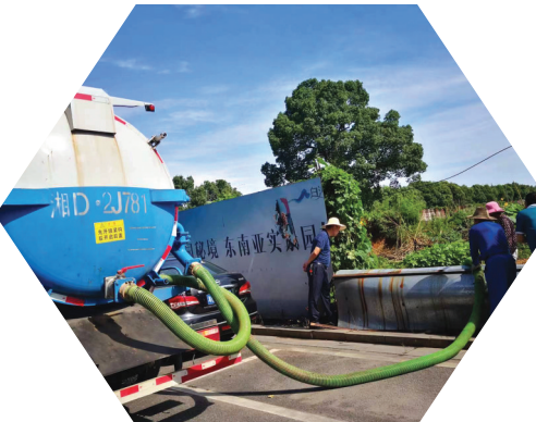
赵家冲路污水管改造及清淤
