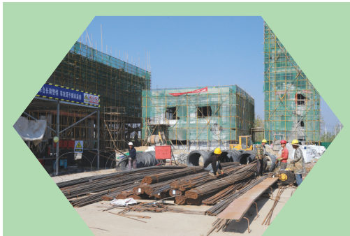
随州高新区青春化工园综合指挥中心项目建设现场
