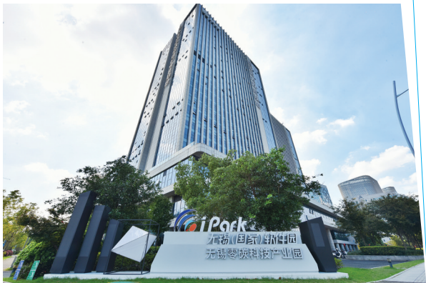
无锡(国家)软件园、无锡零碳科技产业园
