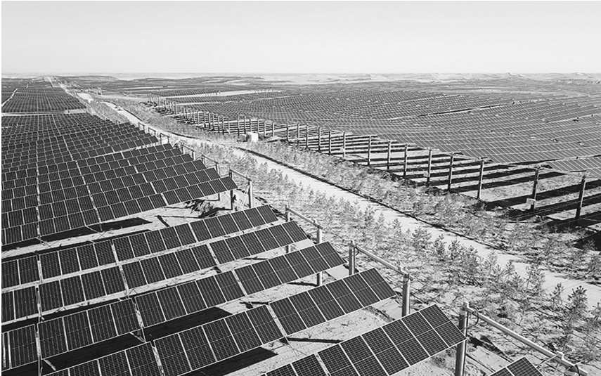
甘肃武威 50 万千瓦立体光伏治沙产业化示范项目 新华社记者 范培坤/摄
