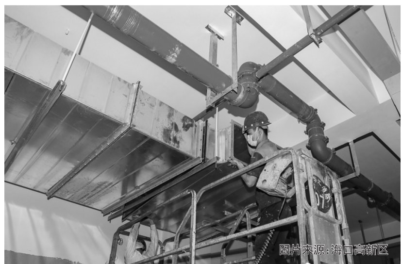
博科海南智能制造总部基地的施工人员正安装施工管道
