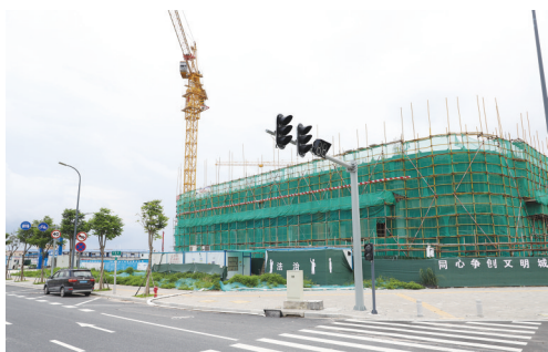
汕头高新区西片区重点项目建设现场
