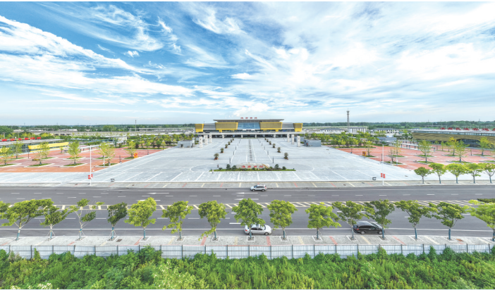
淮南高新区高铁南站
